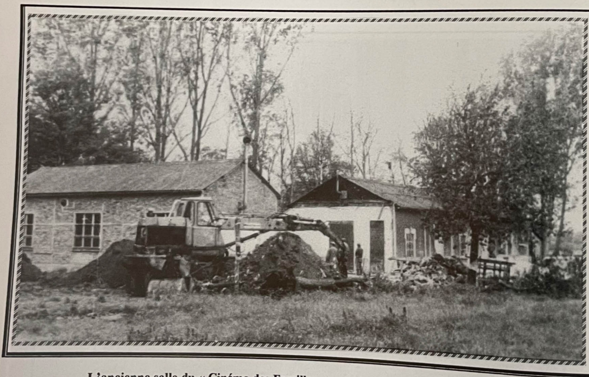
L'ancienne salle du « Cinéma des Familles » avec, à gauche, le bar-salle de jeux, en 1975, lors des travaux de rénovation du Centre Benoît Frachon.
